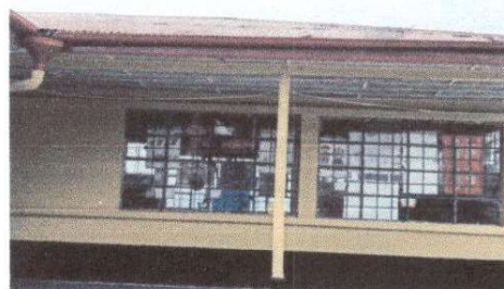
Foto 4: Bajadas de agua reparadas
